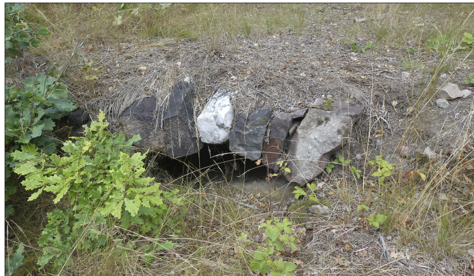
Figur 13. En näst intill osynlig stenvalvsbro L2020:6760. Foton Alf Ericsson.
