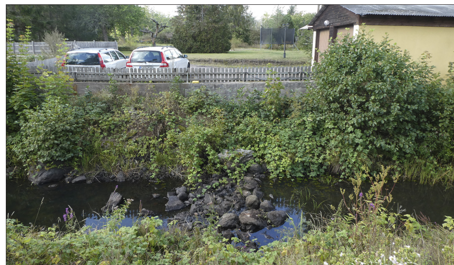
Figur 11. Dammvallen L2020:6723 vid Blommedal har hört till en sågkvarn. Foto Alf Ericsson.
